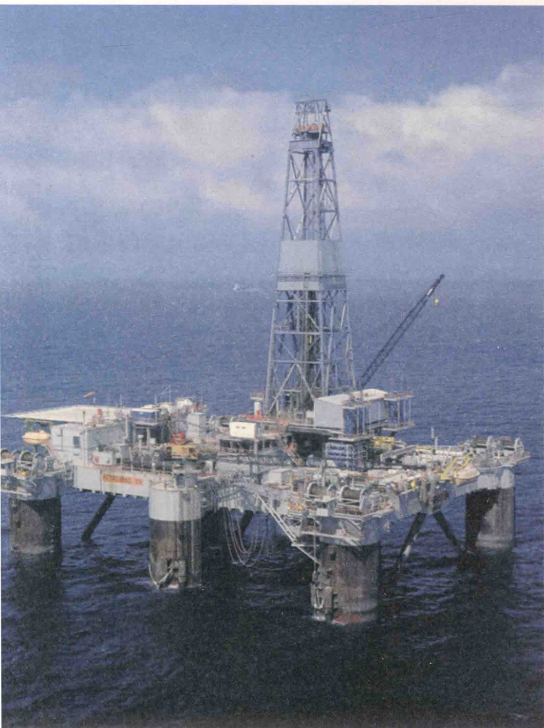
巴西的首个海上钻井平台
